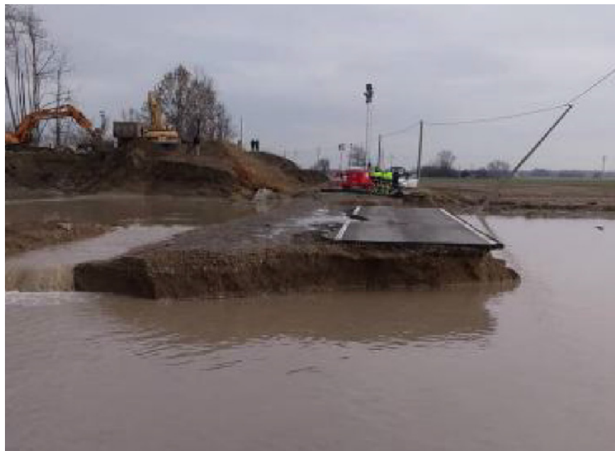
Alluvione del fiume Reno, febbraio 2019
