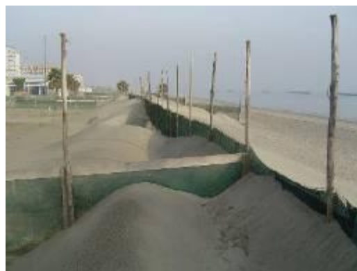
Figura IV.2.3.1.4- esempio di barriera frangivento stagionale
