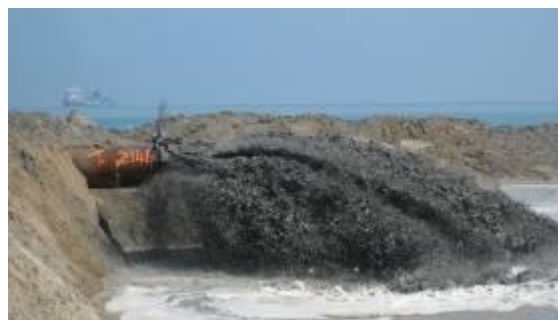
Figura IV.2.3.4.1- ripascimento con sabbie sottomarine
